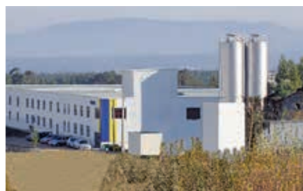
Производственное здание в Падрао
